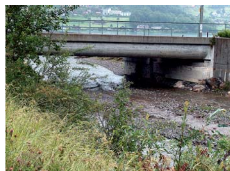
Abb. 9: Baulich-technische Massnahmen in Sachseln (© BWG)
