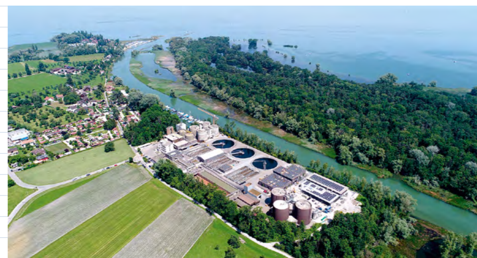
Abb. 10: Abwasserreinigungsanlage ARA Altenrhein bei der Mündung des Alten Rheins in den Bodensee, 2020 (Foto: AVA Altenrhein)
